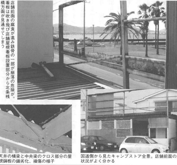
店舗前面の腐食が進み鉄骨の一部が崩落の危険が。看板は吹き飛び店舗屋根看板設置部分から北条棧橋方面が見通せてしまう
